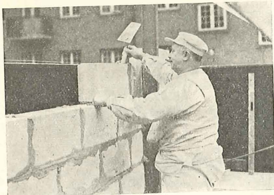
Opmuring af gasbeton
